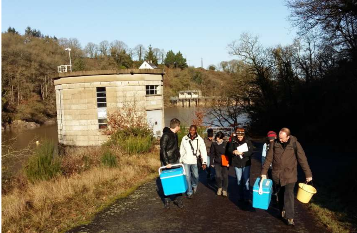
Barrage de Rophémel – Station de potabilisation – le 7 février 2017
